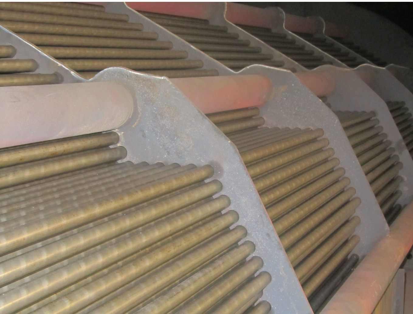
Zdj. Wycięcie części podpór po modernizacji, zwiększające pole przekroju przepływu pary
