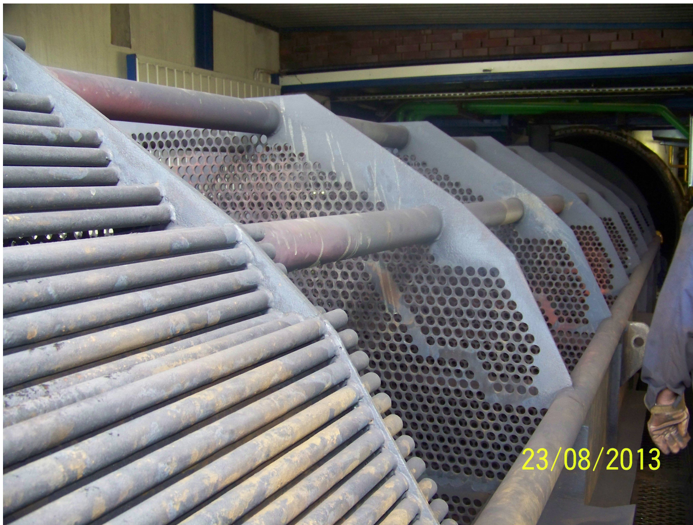
Zdj. Widok podpór wymiennika ciepłowniczego przed modernizacją.
